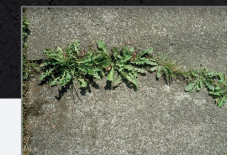
Ukrudt på fortovet
